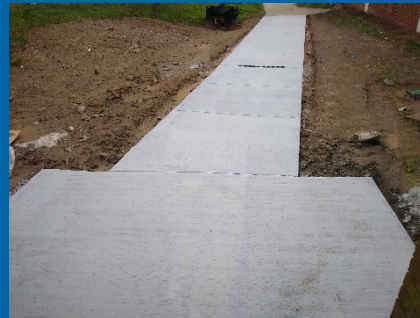
Pour Sidewalks at Connector Courtyard
